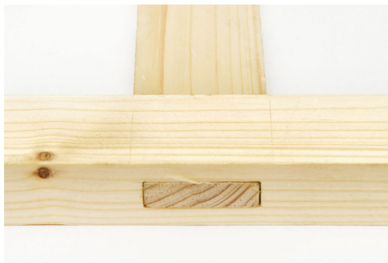
Obr. 18 Průchozí čep a dlab
