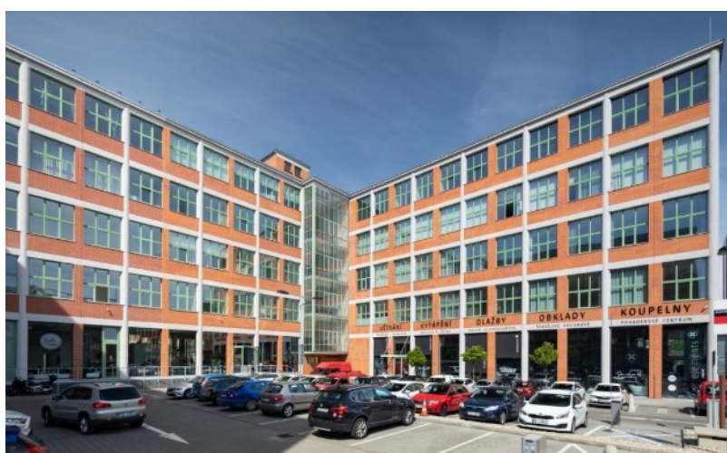
Obrázek 6 HOUSE64 (Zdroj: house64.cz)
