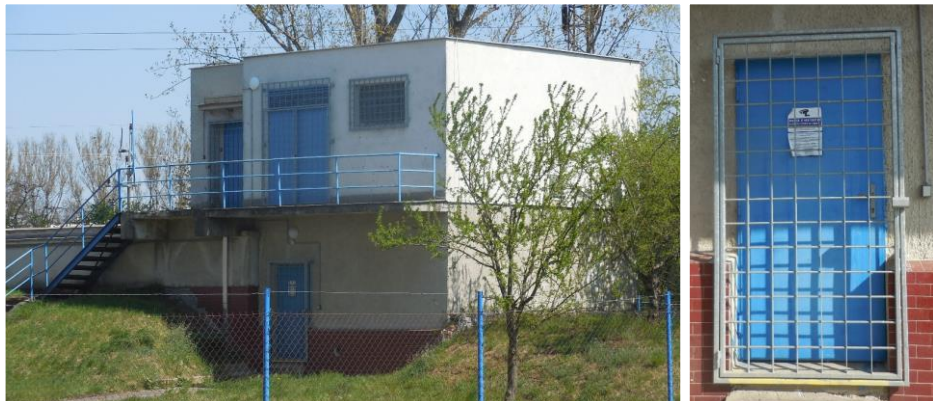
Obrázek 44: Akumulační jímka. [Zdroj: vlastní]
