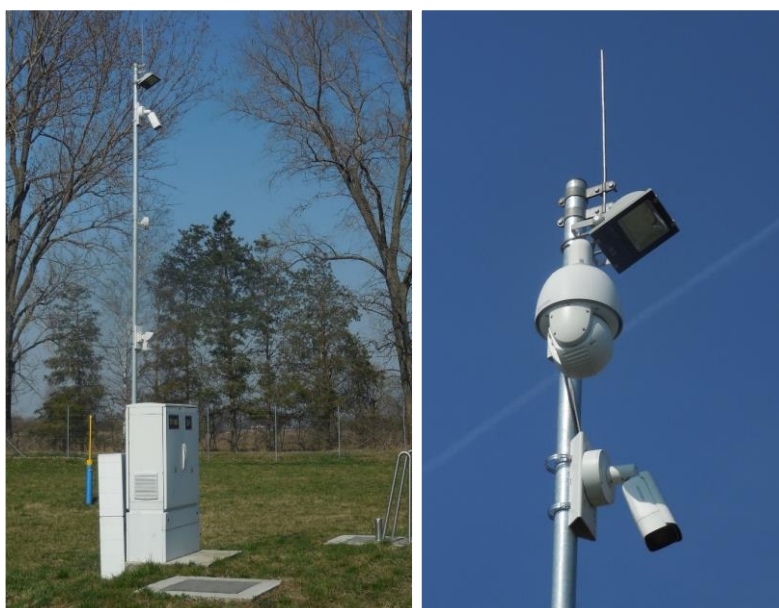
Obrázek 41: Pohled na zabezpečení jímacího vrtu pohybovým čidlem a kamerou s přísvitem. [Zdroj: vlastní]
