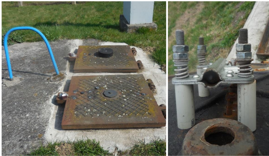
Obrázek 36: Pohled na poklopy jímací studny. [Zdroj: vlastní]
