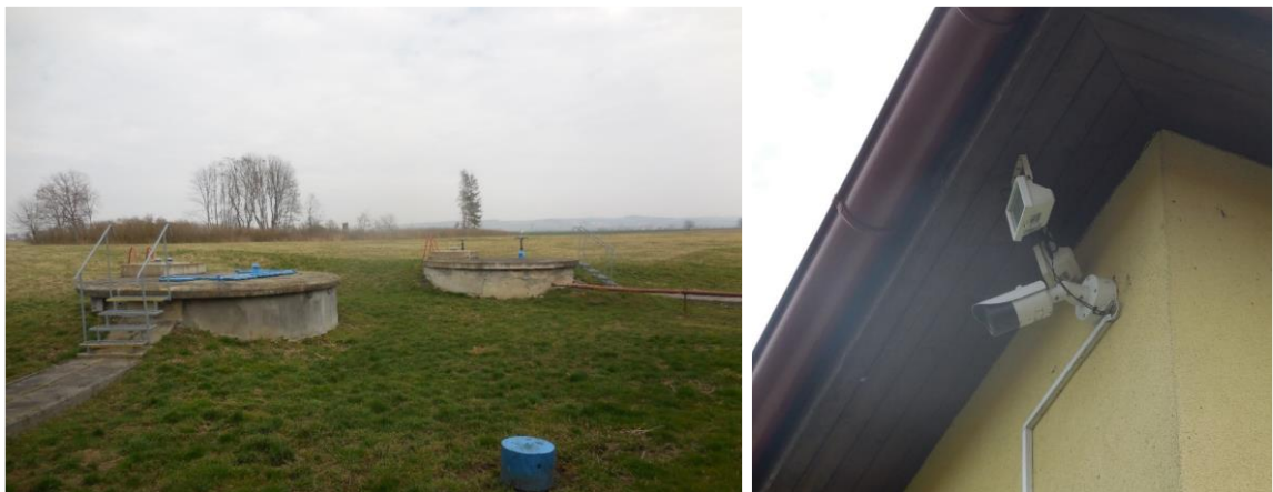
Obrázek 25: Pohled na akumulční jímky a jímku s upravenou vodou. [Zdroj: vlastní]
