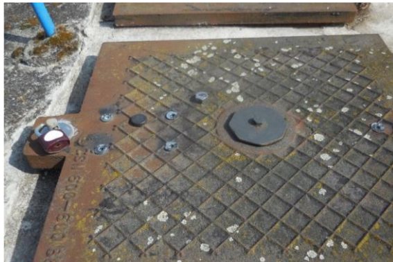
Obrázek 38: Pohled na uzamknutý poklop jímací studny. [Zdroj: vlastní]
