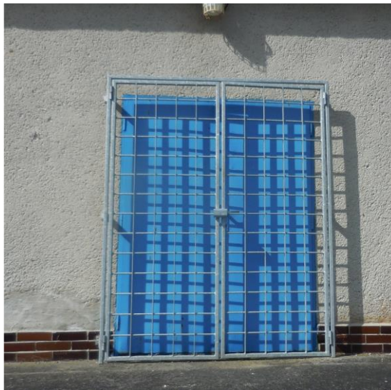
Obrázek 35: Zabezpečení vstupu do objektu akumulční jímky zdroje F [Zdroj: vlastní]
