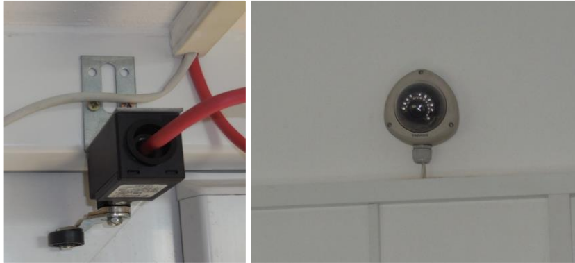
Obrázek 13: Koncový spínač dveří [Zdroj: vlastní]
