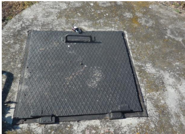
Obrázek 15: Poklop jímací studny [Zdroj: vlastní]
