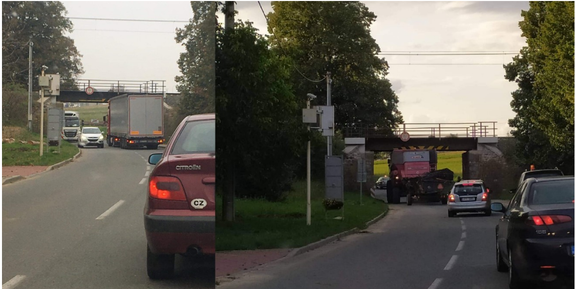
Obrázek 4 Podjezd pod železniční tratí č. 300 u Němčic nad Hanou, zdroj vlastní.
