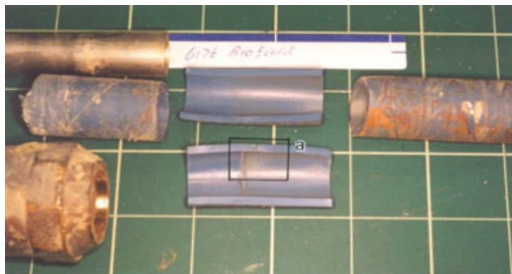
Obr. 14. Porucha poly(1-butenového) potrubí [39]
