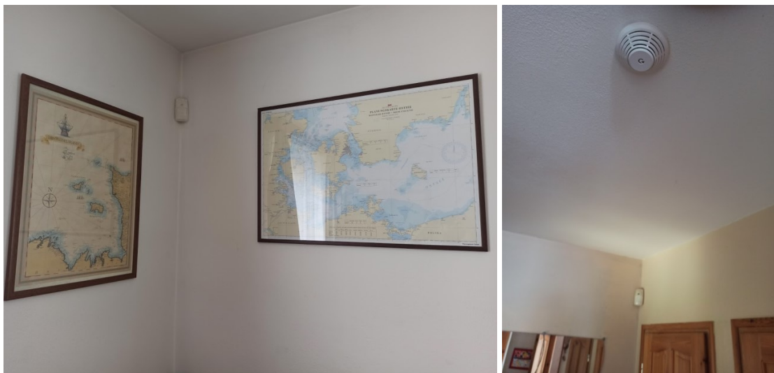
Obr. 9: Detektor pohybu – PIR, PIR a hlásič kouře [vlastní zdroj]
