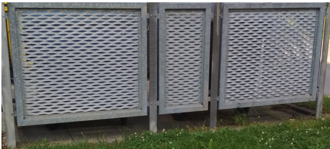
Obr. 20. Ocelová zábranná konstrukce (vlastní zpracování)
