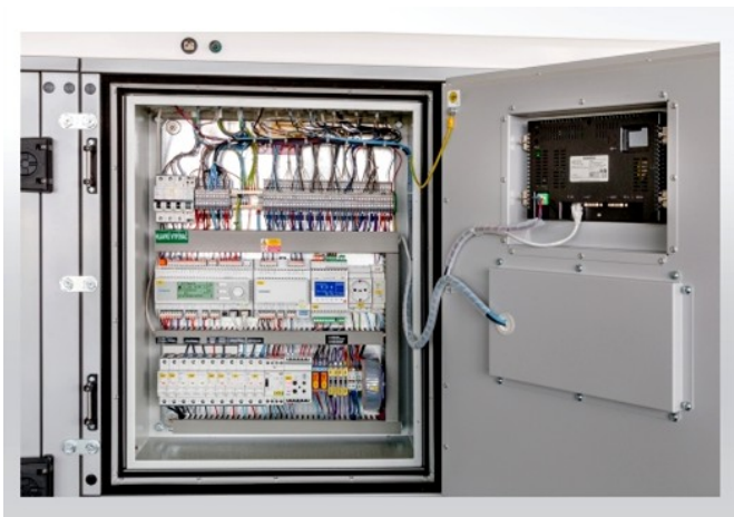
Obr. 6. Regulace vzduchotechnické jednotky [35]
