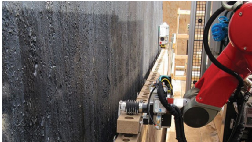
Obrázek 2. Kolaborativní robot SAM100 při stavbě cihelné fasády [7]
