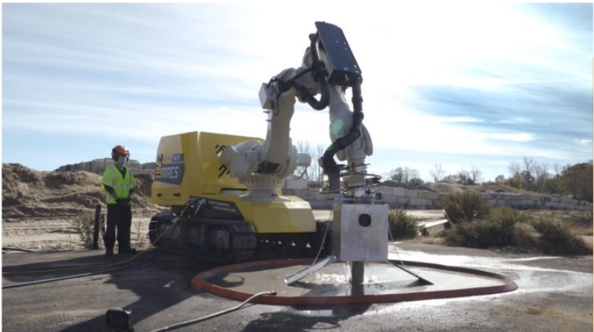
Obrázek 4. Zařízení RRES při řezání otvoru v silnici [11]
