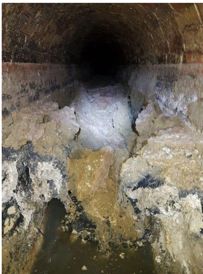
Obrázek 7 Ucpaná kanalizace tukovými balvany [18]
