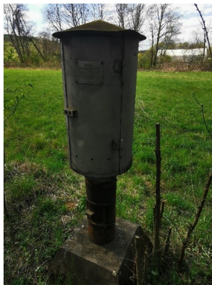
Obr. 34 Nadzemní těleso měrného vrtu VB0186 Biskupice (foto: L. Kužela)
