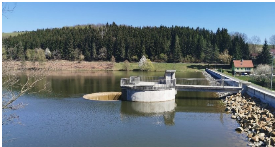
Obr. 27 Manipulační objekt VD Ludkovice (foto: L. Kužela)
