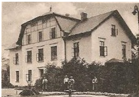
Obrázek 3 Hospodářská budova a byty sester v Orlové
