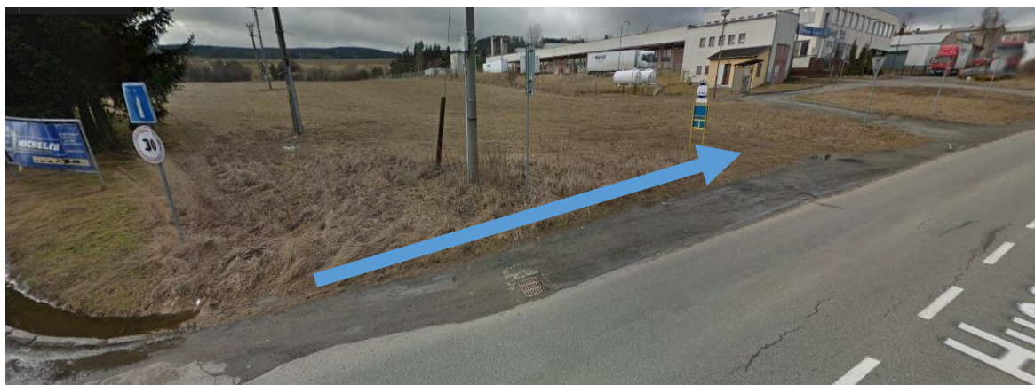
Obr. 5. Místo realizace (levá strana), chybějící komun. pro pěší a aut. zastávka
