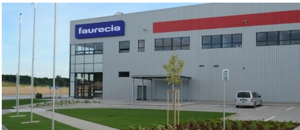
Obrázek 1 Budova Faurecia Lozorno (V – statik, © 2020)
