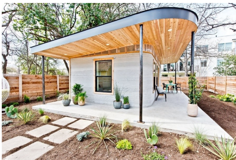
Obr. 4 – 3D vytisknutý dům (ICON PR, 2018)
