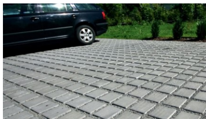
Obr. 18: Zámková dlažba
