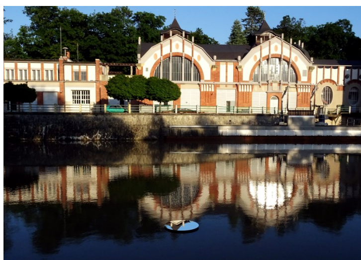
Obrázek 21 vodní elektrárna Hučák
