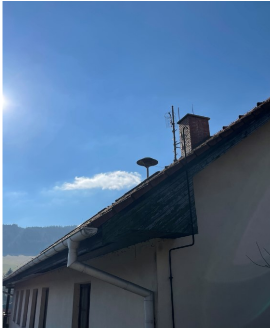
Obrázek 23: Rotační siréna v obci
