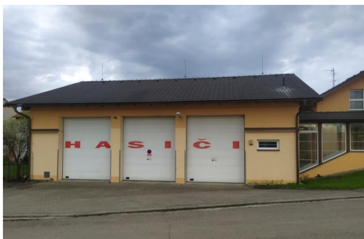
Obr. 5 Požární zbrojnice JSDHO Bylnice – garáže (vlastní)
