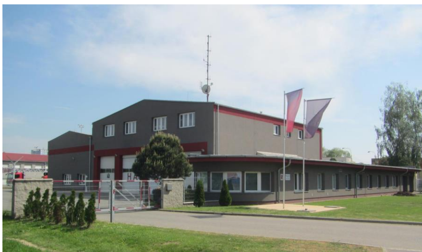
Obrázek 15: Požární stanice Otrokovice (HZS, 2021)
