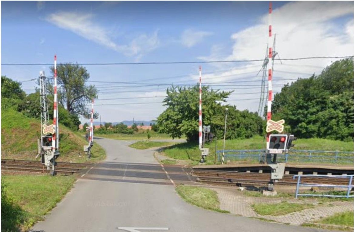
Obr. 9 Přímý pohled na místo havárie (Železniční přejezd P8172 Hulín-Záhlinice, 2014)
