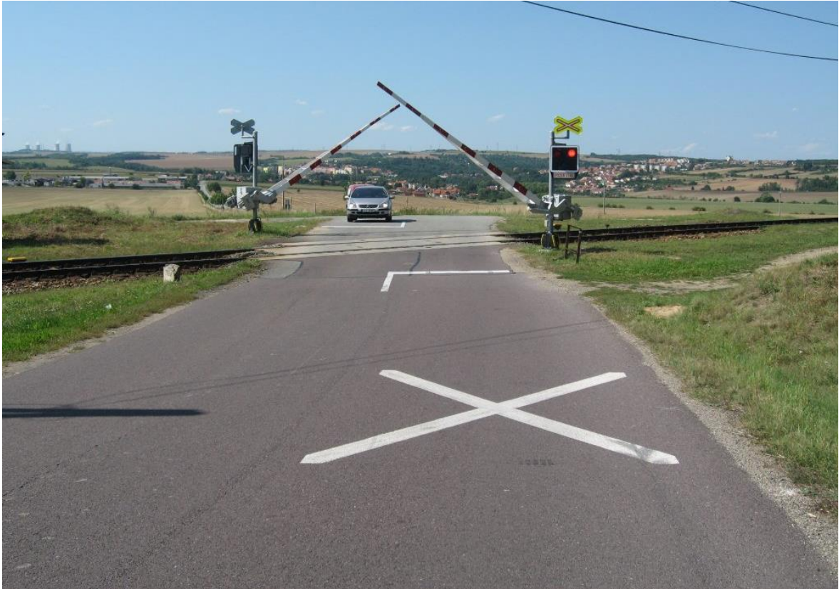
Obr. 21 Symbol výstražného kříže na vozovce (Observatoř, 2012)
