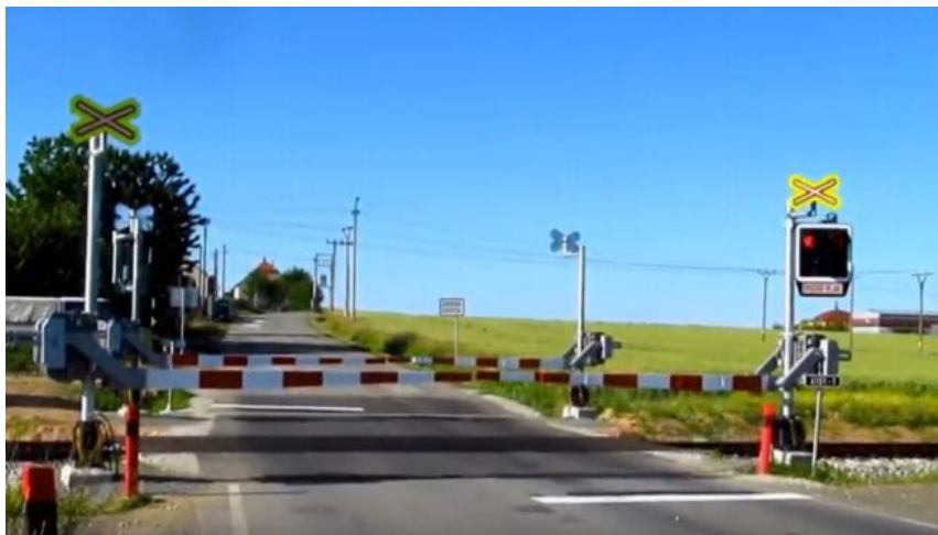
Obr. 23 Druhá fáze sklápění břeven (Zahradník, 2019)
