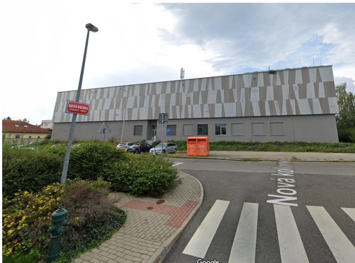
Obrázek 5: Nejnovější datacentrum O2 ve Stodůlkách (zdroj: Google Maps)
