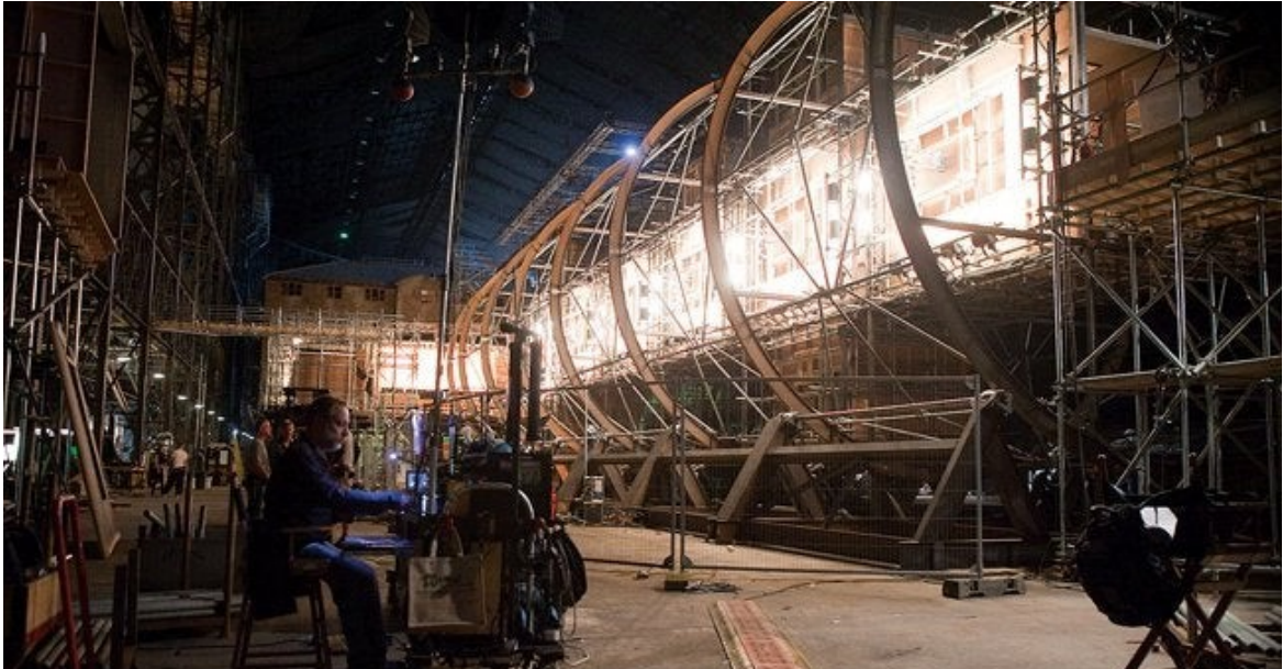
Obrázek 13 Vnější pohled na trikovou dekoraci rotující chodby včetně mechanického zařízení na její otáčení
