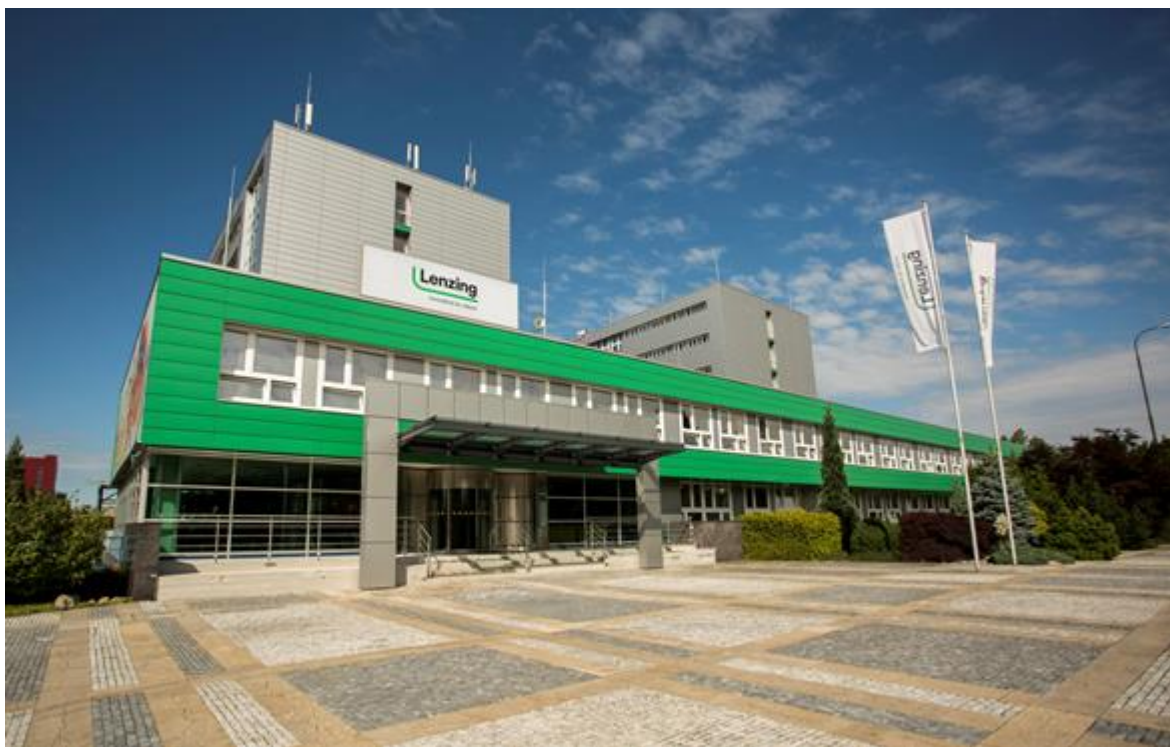
Obrázek 6 Centrální budova LBP a.s. (interní dokumentace)
