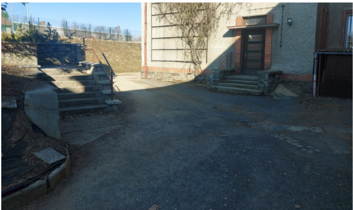
Obrázek 4 Únikový východ a schodiště vedoucí ke shromažďovacímu prostoru (vlastní)
