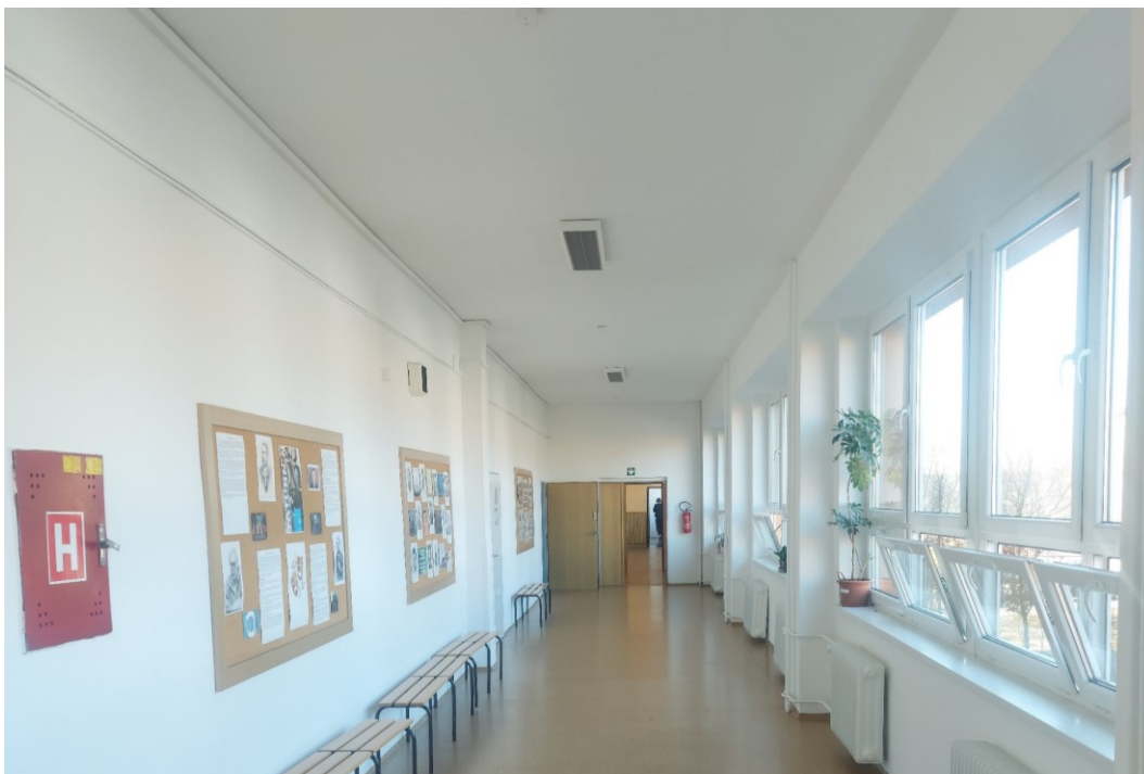
Obrázek 13 Chodba s otevřenými požárními dveřmi (vlastní)
