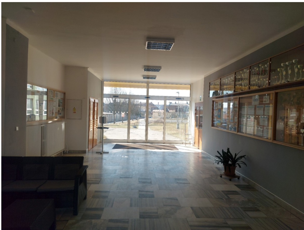
Obrázek 10 Dveře bez označení únikového východu (vlastní)
