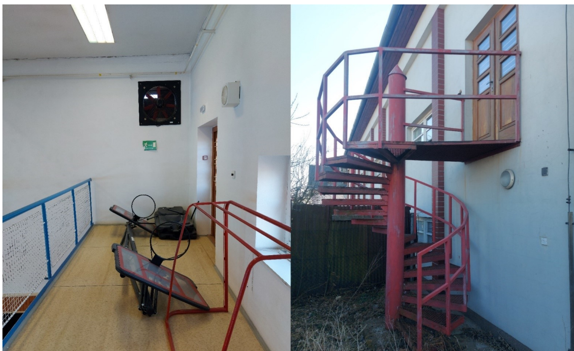
Obrázek 8 Únikový východ a venkovní schodiště z objektu (vlastní)
