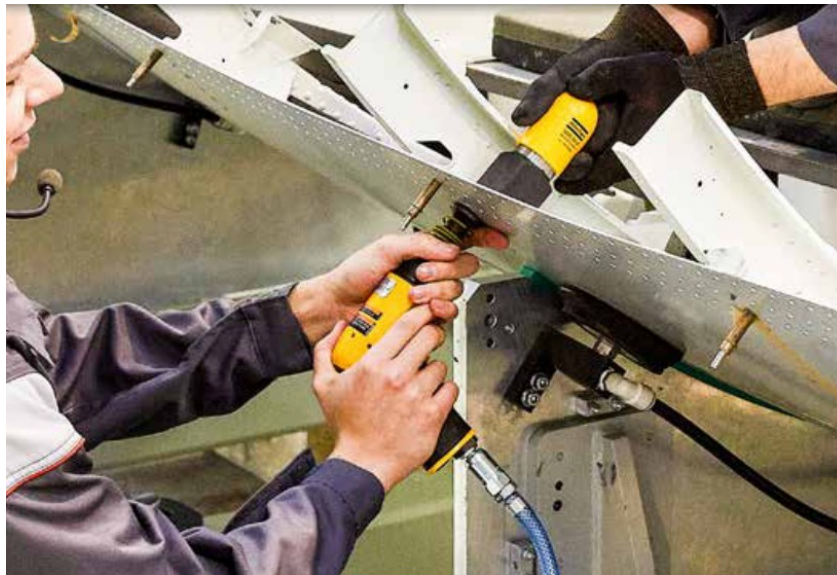
Obr. 23: Zhotovení nýtového spoje pomocí pneumatického nýtovacího kladiva a nýtovací opěrky [30]
