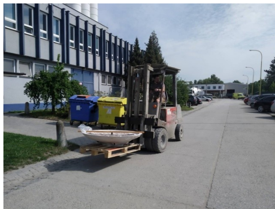
Obr. 60 Vykládání v betonárně
