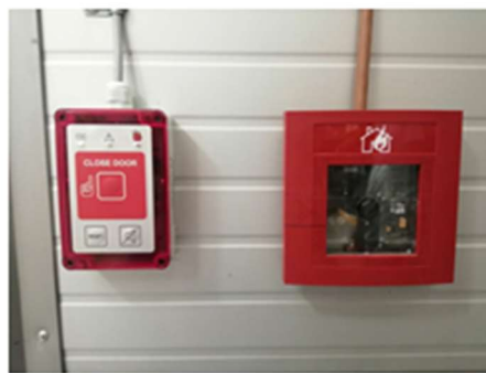
Obrázek 21 - Vrata s nehořlavými roletami a požární hlásič (vlastní)
