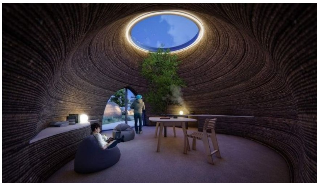
Obr. 62.: Ukázka budovy zhotovené pomocí 3D tisku [31]
