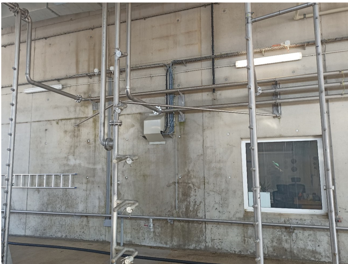
Obr. 7 Trysky ostřikovacího rámu (vlastní)
