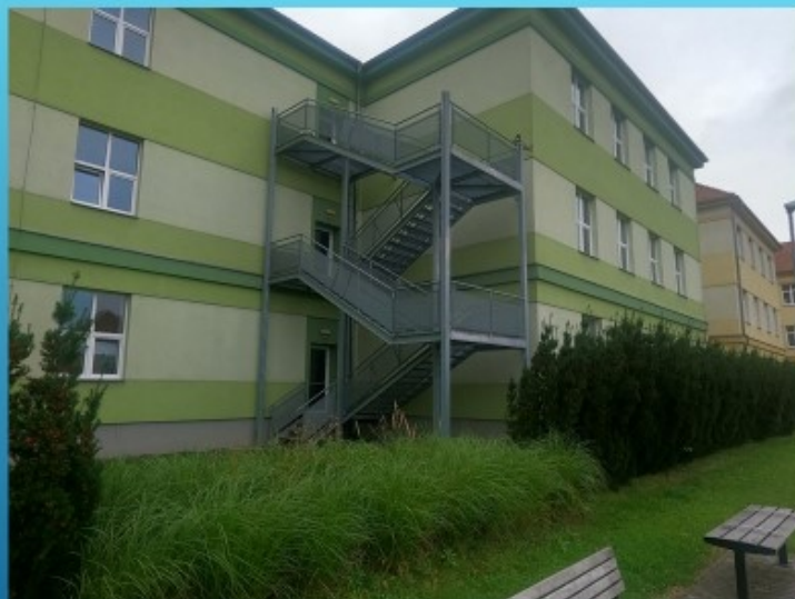
Obr. 8 – Nouzové schodiště (zdroj: vlastní)
