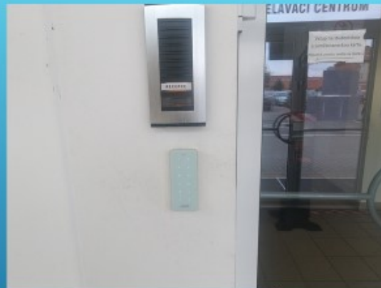
Obr. 4 – Zabezpečení hlavního vstupu (zdroj: vlastní)
