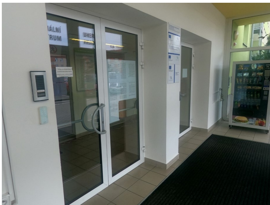
Obrázek 17 Vstupní dveře s elektronickou kontrolou vstupu, UH 1 (zdroj: vlastní)
