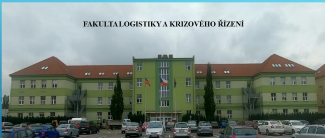
Obr. 2 - Pohled na budovu UH 1 (zdroj: vlastní)
