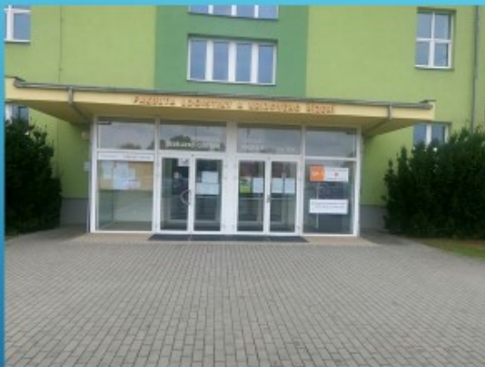
Obr. 3 – Hlavní vstup do budovy UHI (zdroj: vlastní)
