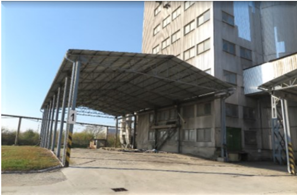
Obrázek 9. Pohled na objekty příjmových roštů, zdroj: autor
