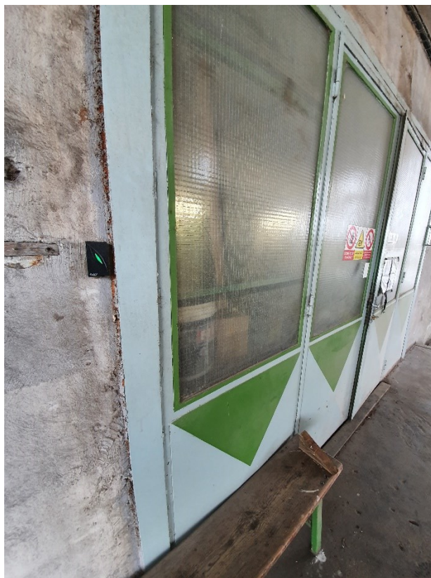
Obrázek 63. Instalace PZTS a ACS 6, zdroj: autor
