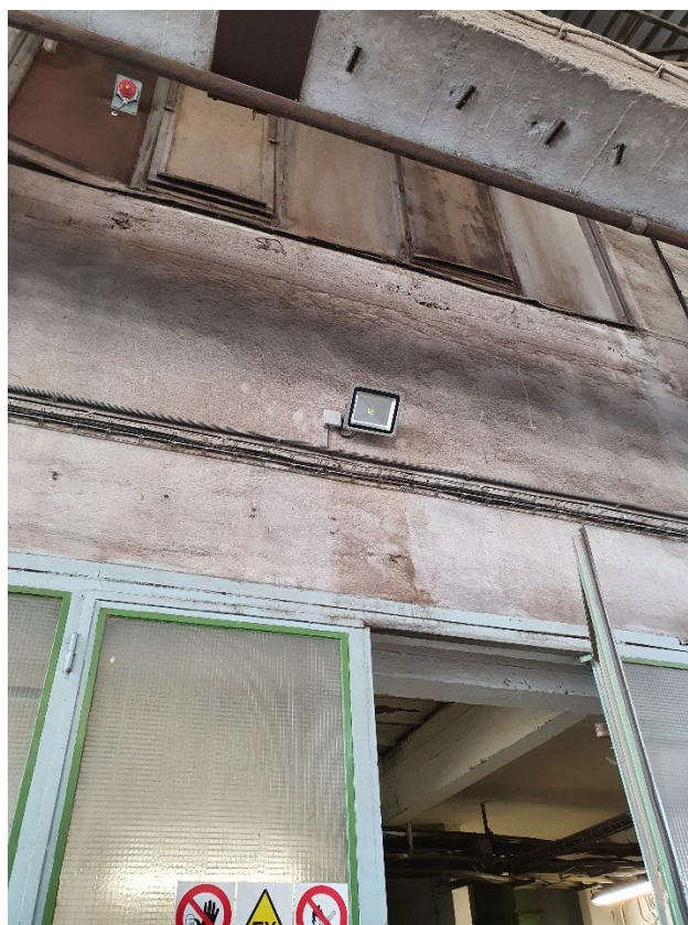
Obrázek 64. Instalace osvětlení, zdroj: autor
