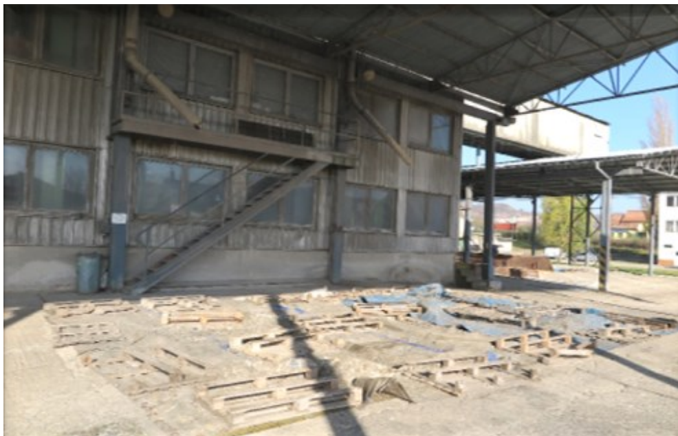
Obrázek 10. Pohled na detail příjmových roštů, zdroj: autor
