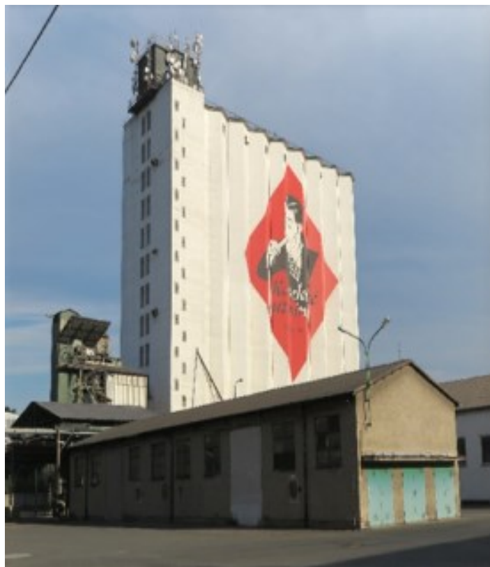
Obrázek 11. Pohled na silo, zdroj: autor
