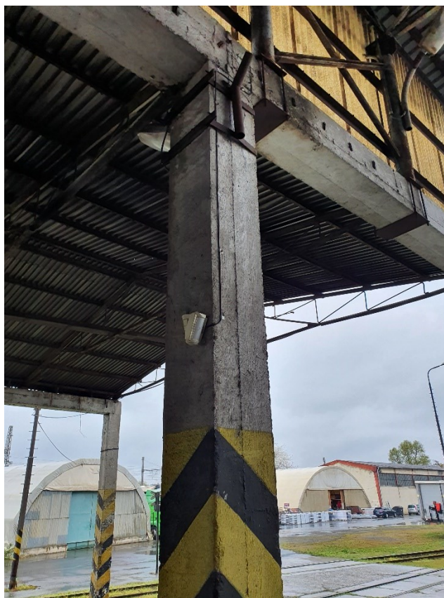
Obrázek 66. Instalace PZTS a osvětlení 9, zdroj: autor
