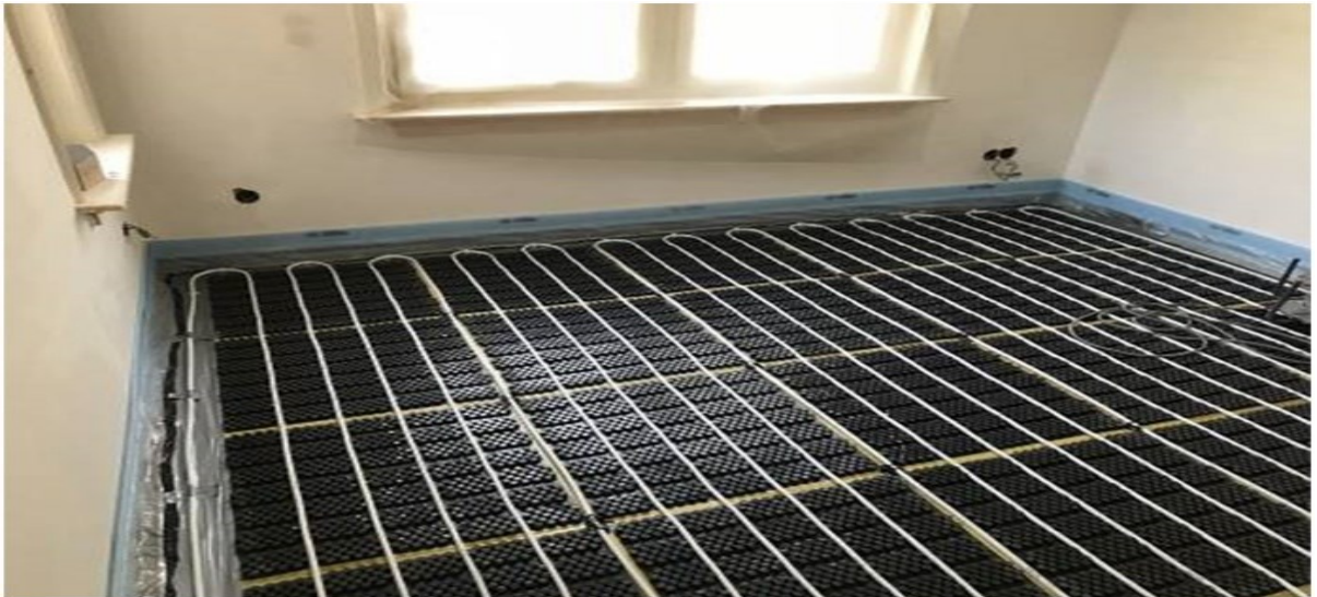
Obr. 13: Podlahové vytápění (PCM Technology) (27)
