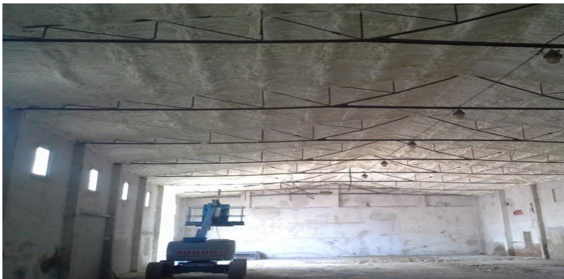
Obrázek 31 Zateplení skladu PUR pěnou
