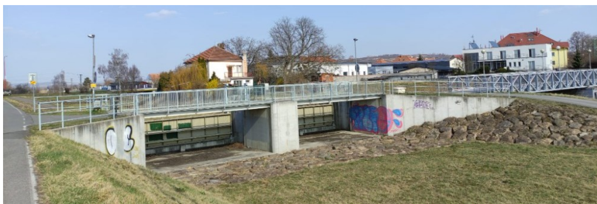
Obrázek 3 – Část vodního ochranného systému u Baťova kanálu (zdroj vlastní)
