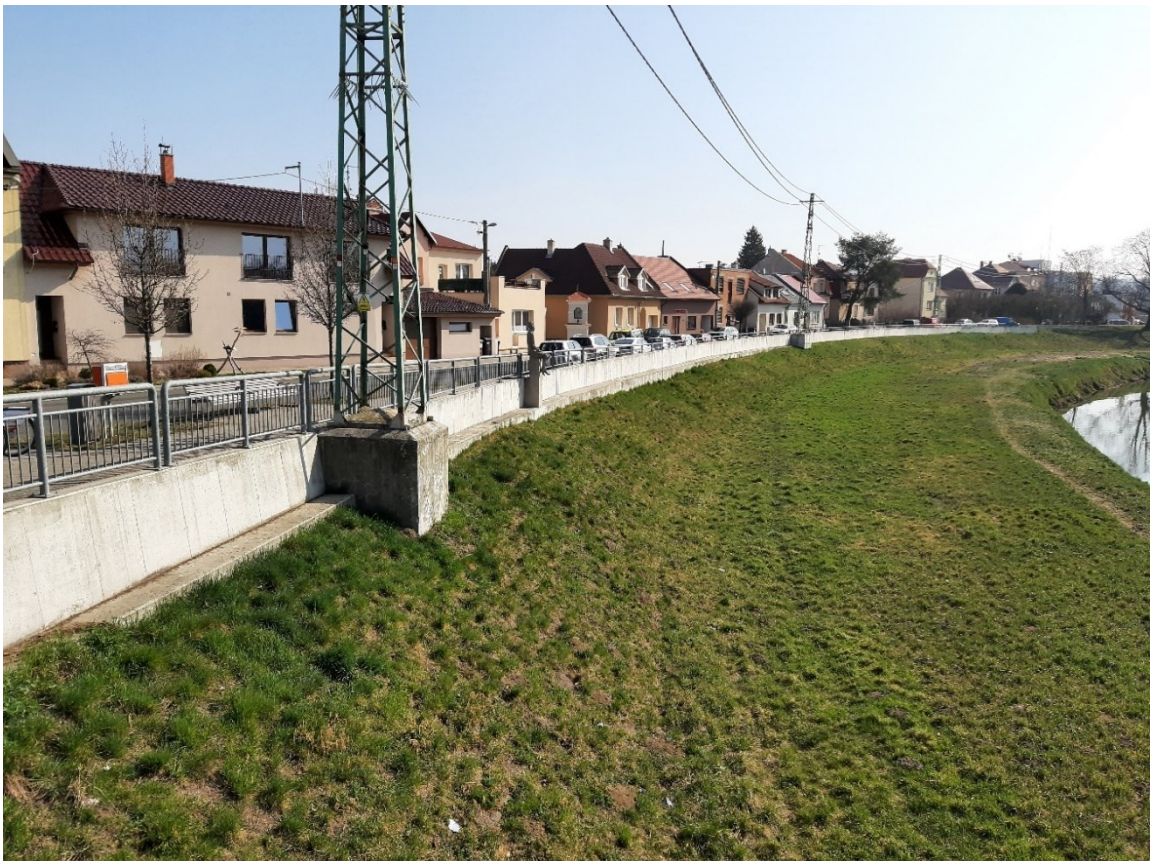
Obrázek 5 – Kombinace zemních valů a betonových zdí v části Rybárny (zdroj vlastní)
