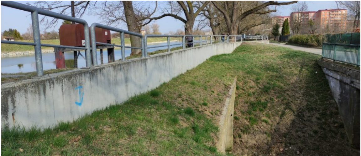
Obrázek 4 – Ochranné hráze u přítoku Staré Olšavy ve Štěpnické ulici (zdroj vlastní)
