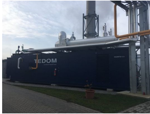
Obrázek 3 Kontejnerová kogenerační jednotka (vlastní zpracování)
