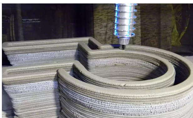
Obrázek 22 – 3D tisk betonu
