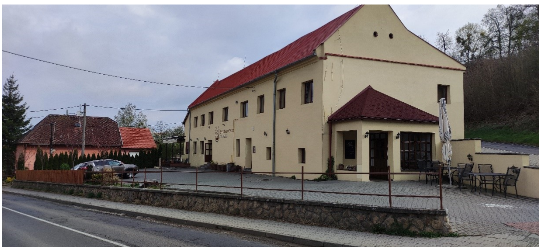
Obrázek 30 Objekt modernizace kamerového systému
