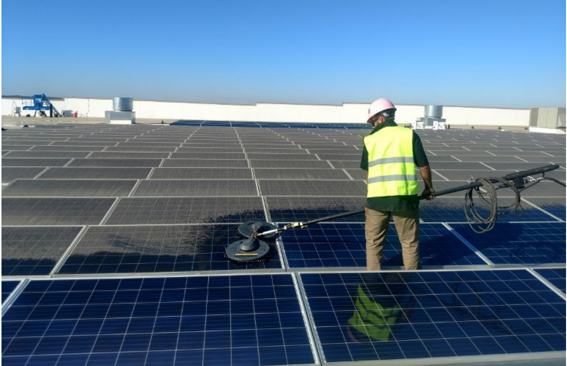
Obrázek č.17 Znázornění údržby FV panelů [7]
