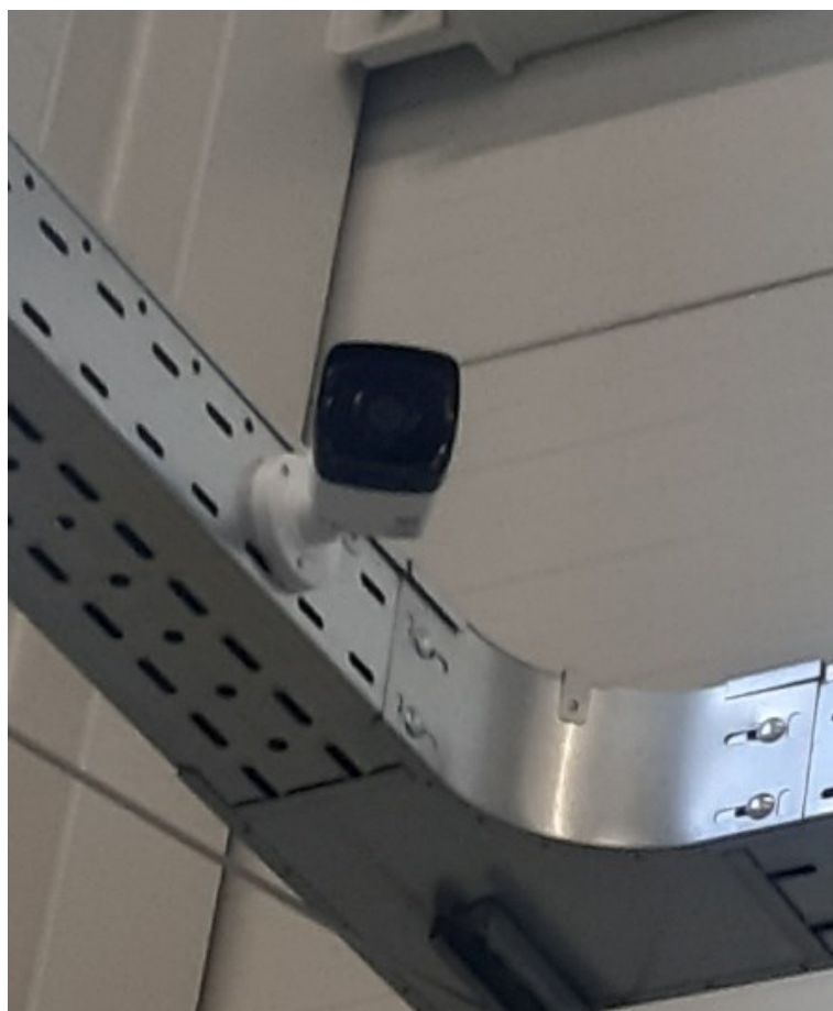
Obrázek 25. Uchycení bezpečnostní kamery. [Vlastní]
