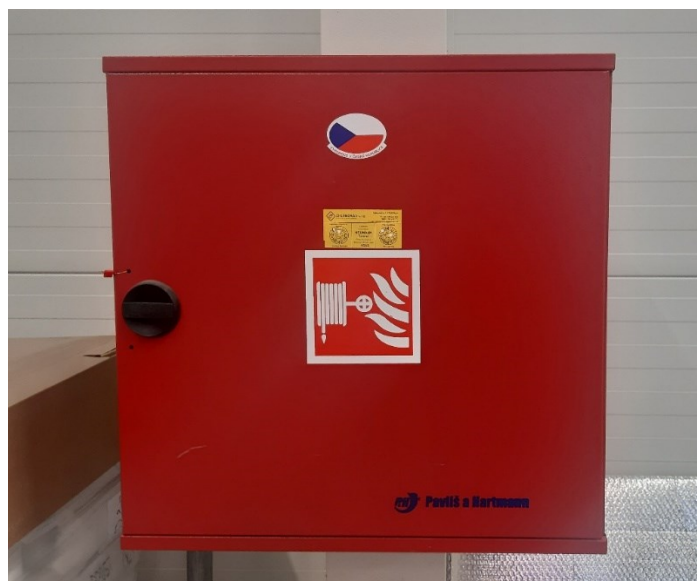
Obrázek 17. Požární hydrant. [Vlastní]
