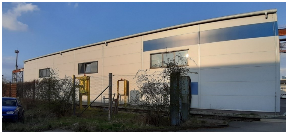
Obrázek 8. Zadní část budovy skladu. [Vlastní]
