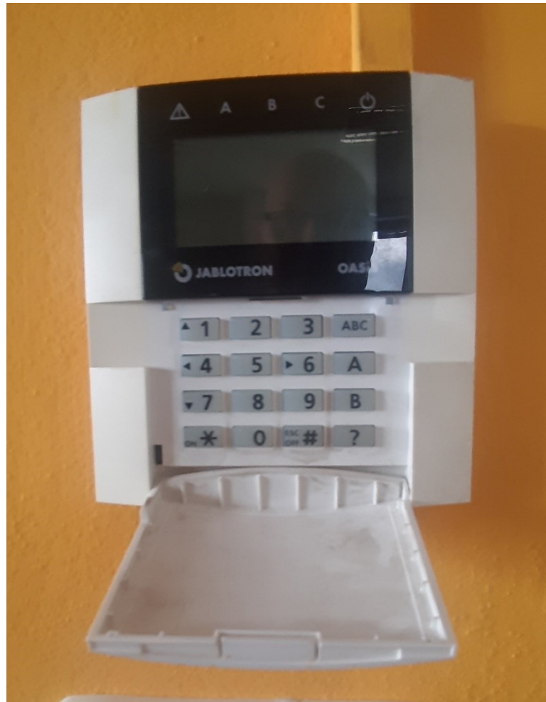
Obrázek 19. Nefunkční klávesnice systému PZTS. [Vlastní]
