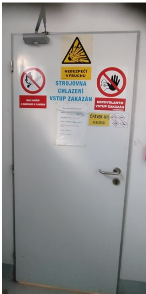
Obrázek 12 Vstup do strojovny
