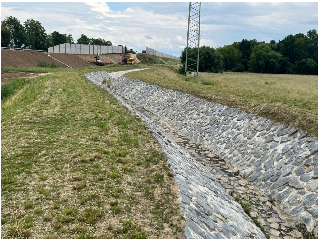
Obrázek 11 Vytvořené koryto na odtok vody z dálnice (Zdroj: vlastní)
