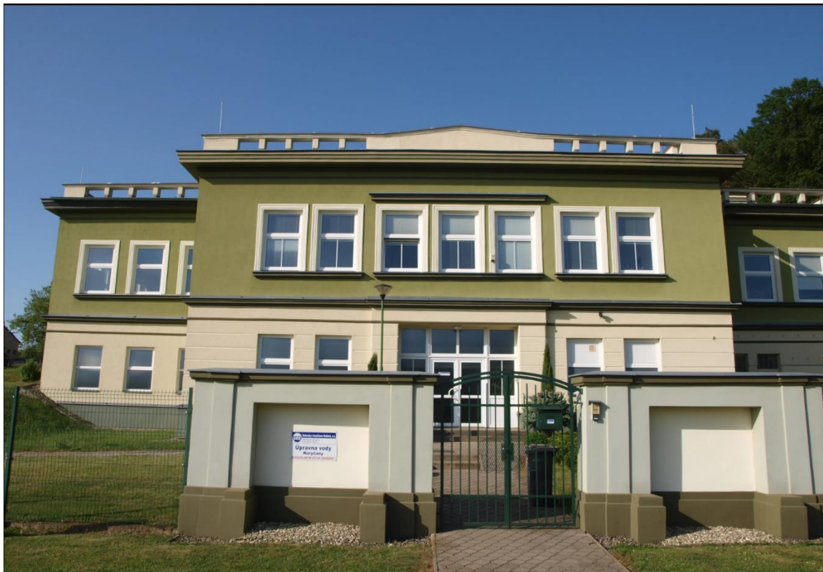
Obrázek 10: Úpravna vody Koryčany
