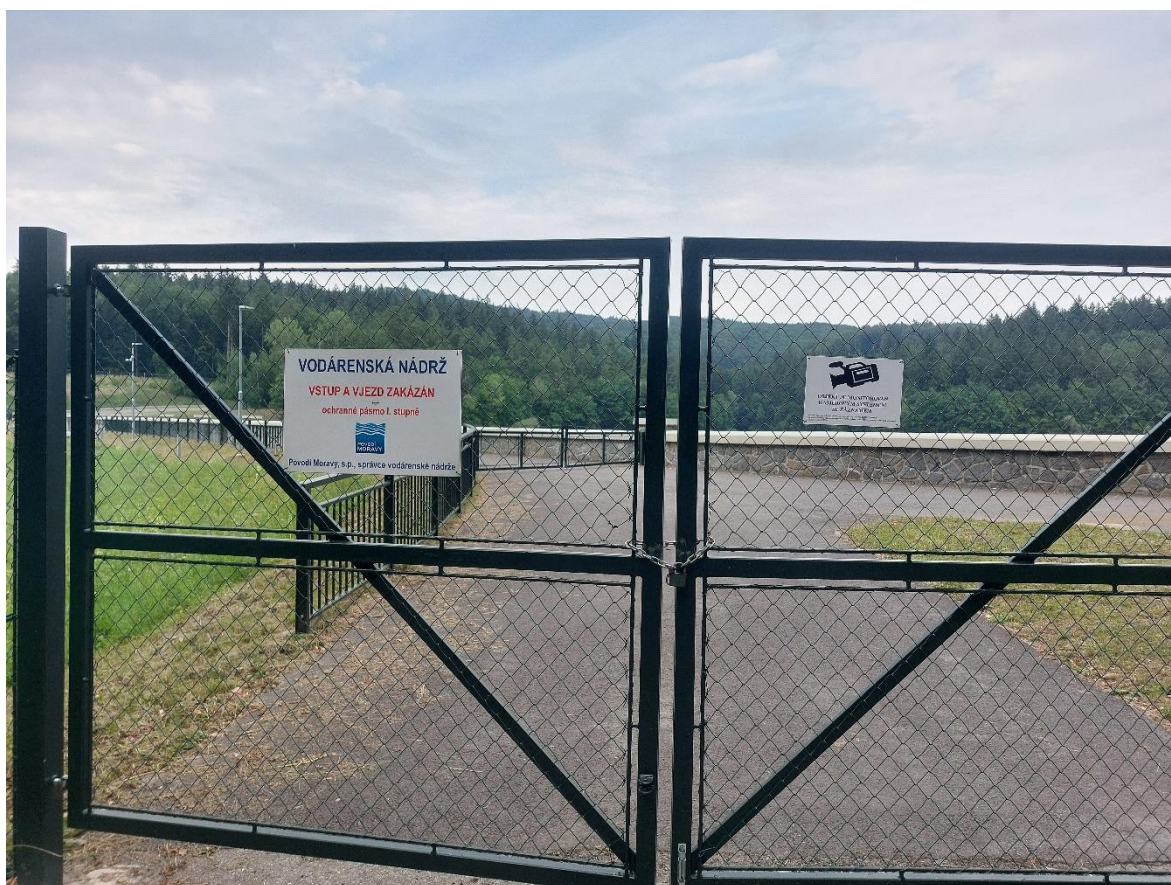
Obrázek 13: Brána horní části hráze Koryčany
