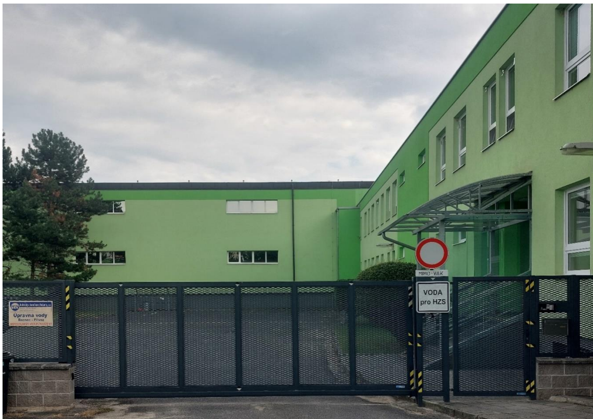
Obrázek 9: Úpravna vody Bzenec
