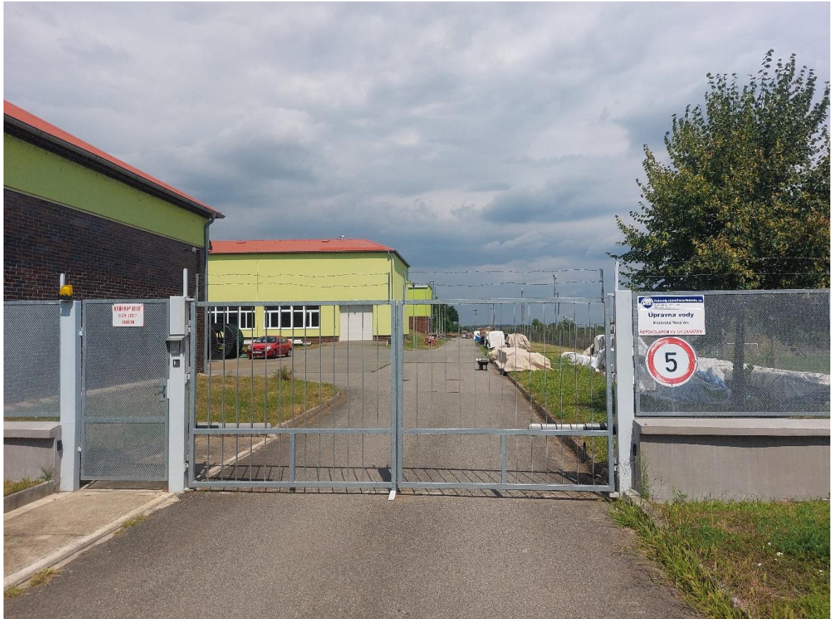
Obrázek 6: Úpravná vody Moravská Nová Ves – vstupní brána
