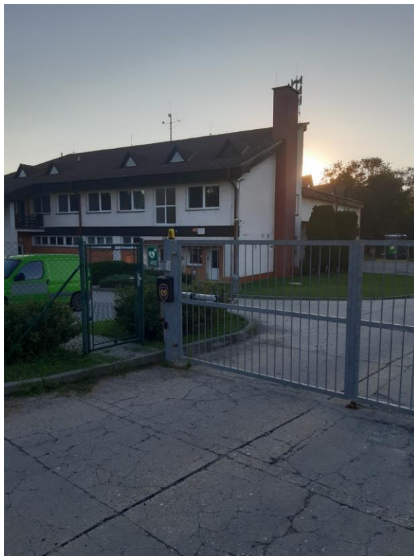
Obrázek 2 – Hasičská stanice Veselí nad Moravou
