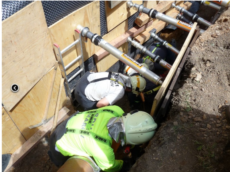
Obrázek 15 Vytvoření pažení Hořovice (Tragický zával osoby ve výkopu v Hořovicích, © 2023)
