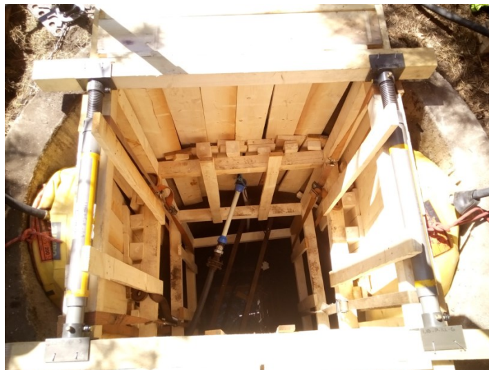
Obrázek 11 Rekonstrukce pažení 2 (HZS JmK, 2023)
