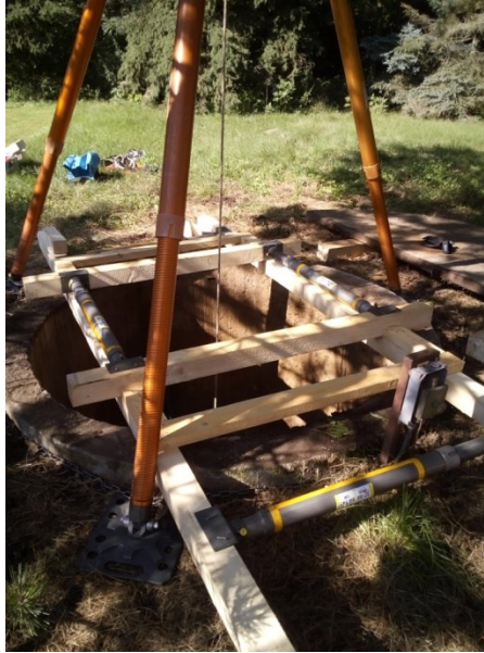
Obrázek 10 Rekonstrukce pažení 1 (HZS JmK, 2023)
