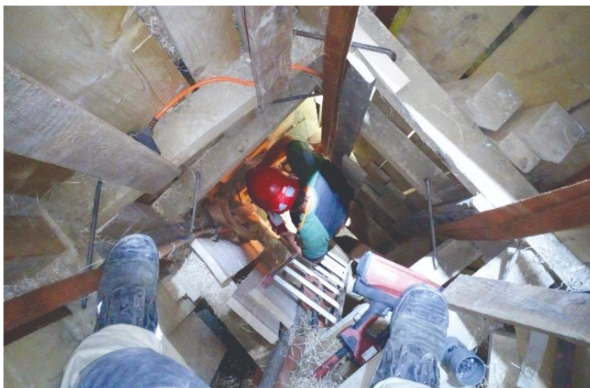
Obrázek 14 pažení studny Velké Pavlovice (HZS JmK, 2023)
