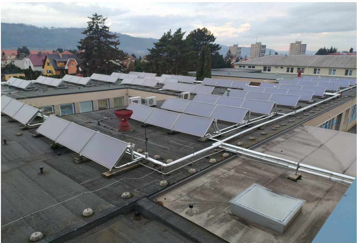
Obr. 3 Instalace solárního kolektoru nemocnice Blansko (budova C)
