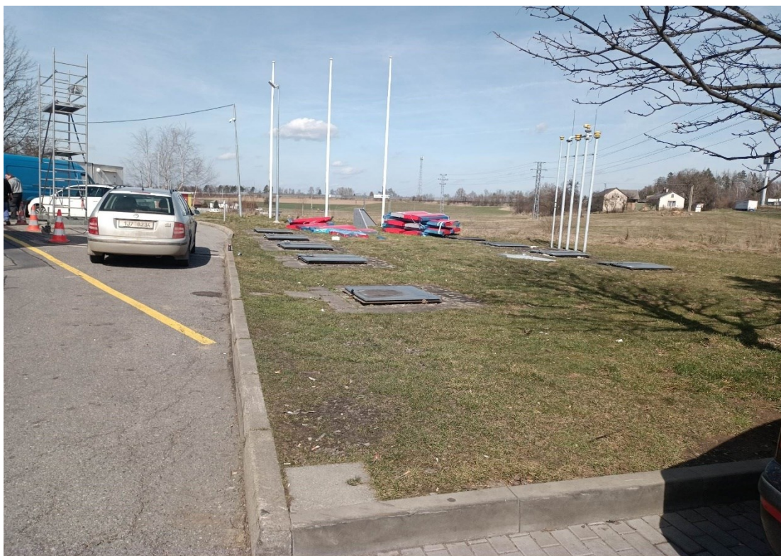
Obrázek 12 ORLEN Benzina – Vystrkov Plnicí šachty (vlastní)
