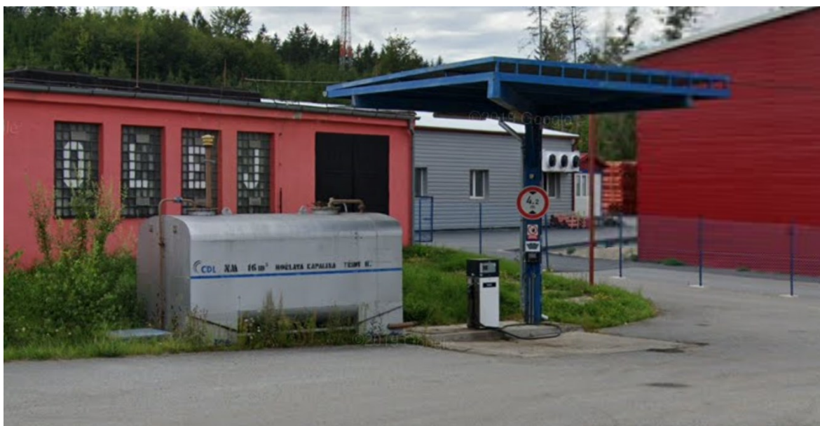
Obrázek 22 Čerpací stanice v Komorovicích (Google mapy 2023)
