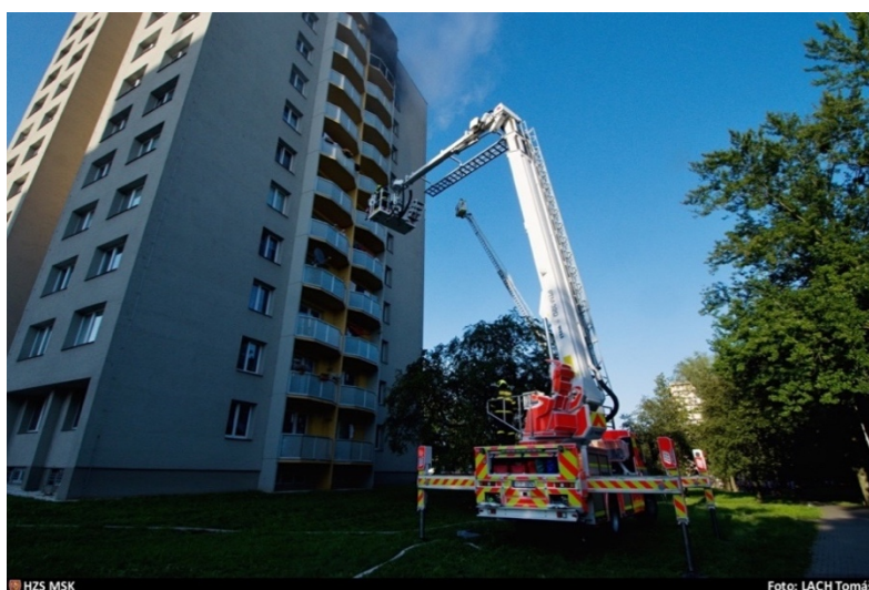
Obrázek 1 Požár bytu Bohumín (Informace o požáru, 2020)
