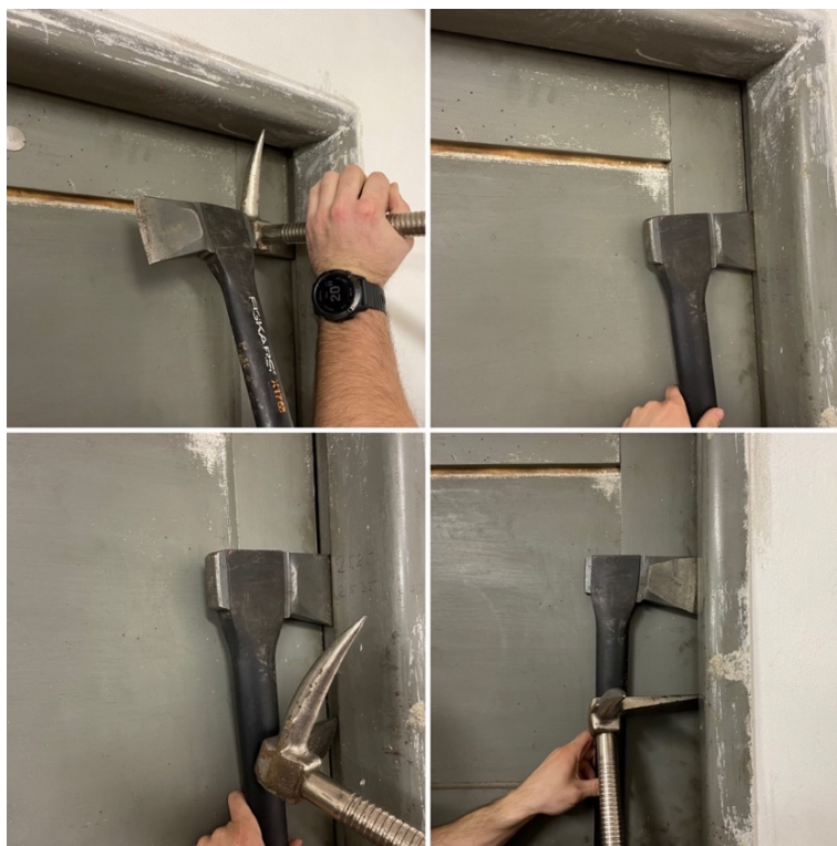
Obrázek 15 Destruktivní otevření dveří (Autor, 2023)
