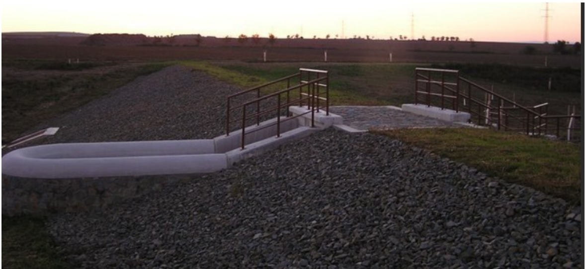
Obrázek 9 – Horní nádrž po dokončení (Bezměrov, 2007)
