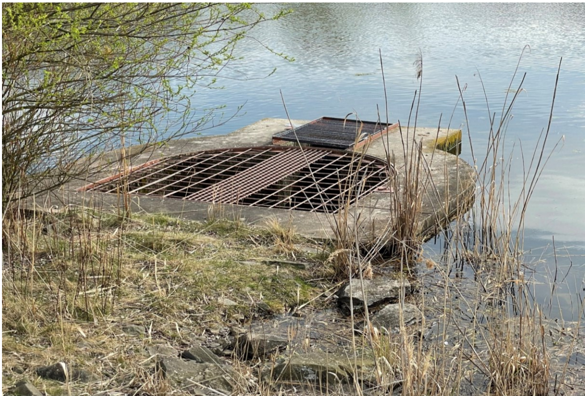
Obrázek 13 – Výpusť z poldru (vlastní)
