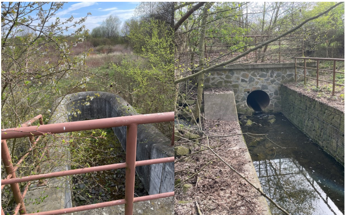
Obrázek 10 – Současný stav horní a dolní nádrže (vlastní)
