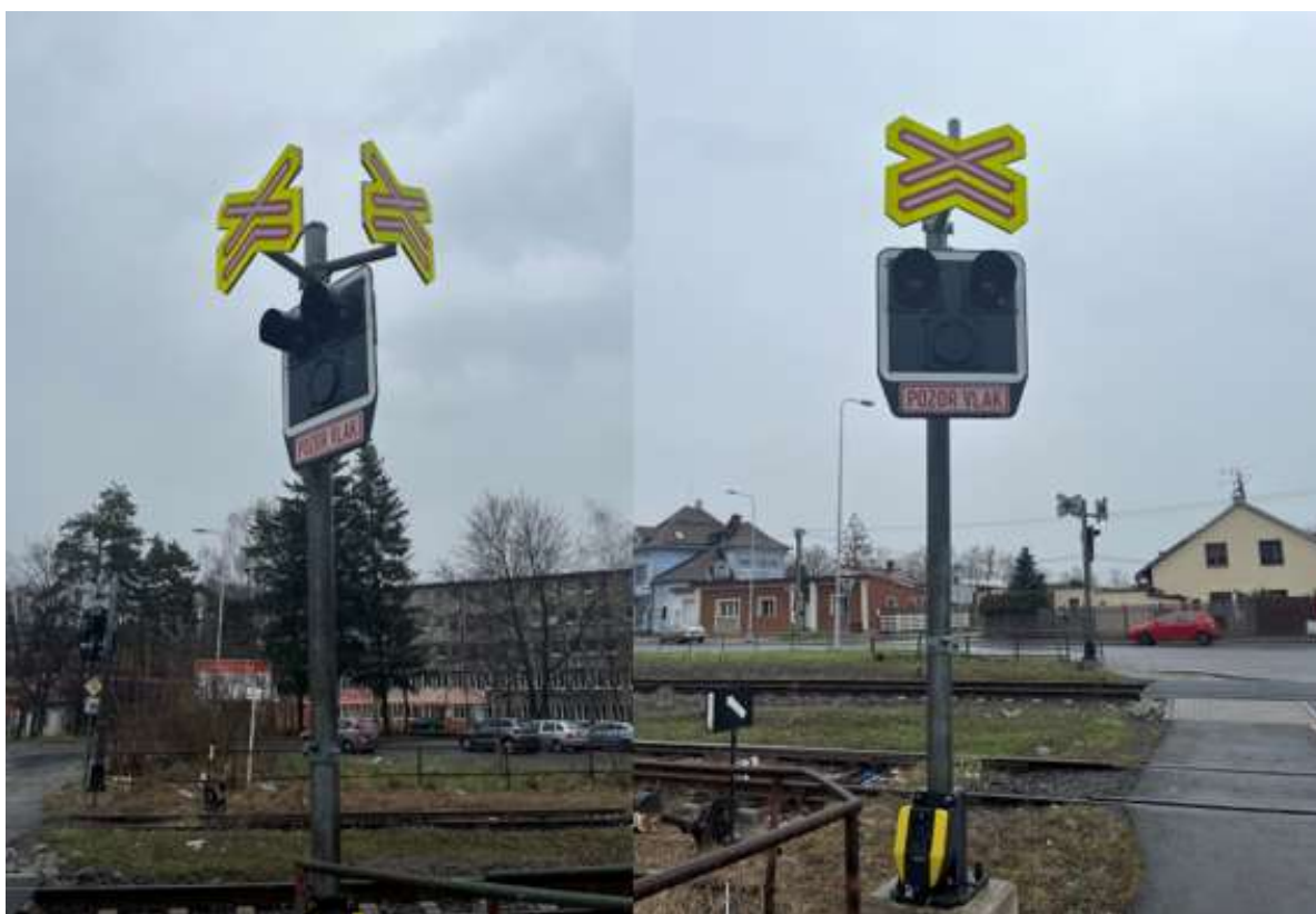
Obrázek 10 Světelná signalizace na přejezdu P7405
