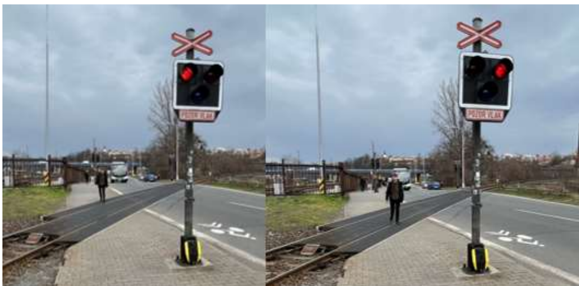
Obrázek 14 Porušení bezpečnosti na přejezdu P8299
