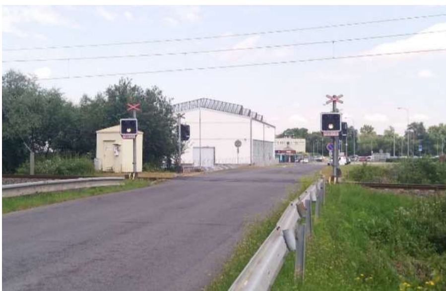
Obrázek 7 Železniční přejezd P7744
