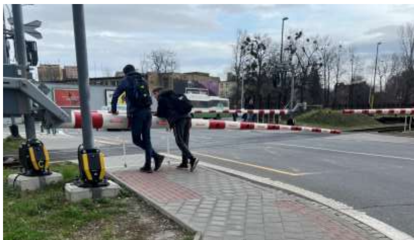
Obrázek 20 Vandalismus na sekvenčních závorách
