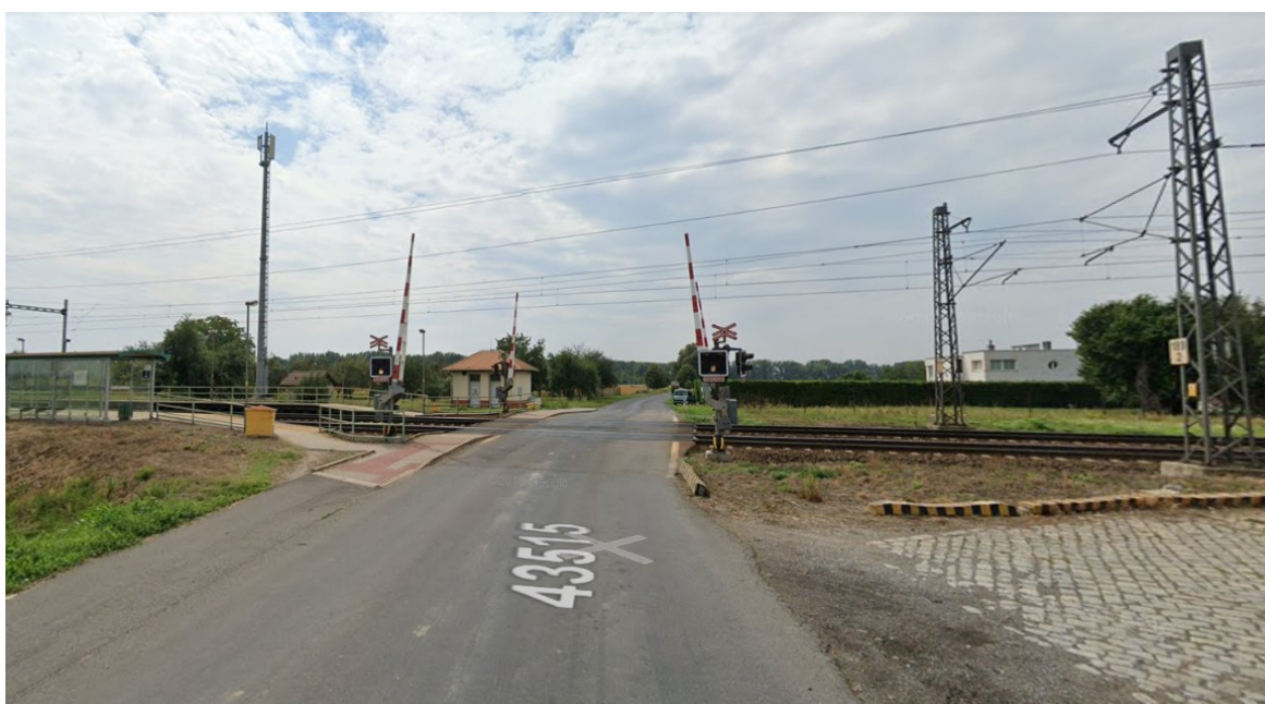
Obrázek 3 – Železniční přejezd v obci Rokytnice. ( google.maps, 2023 )
